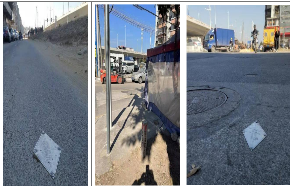
图 7 警示标识现场照片（由左至右对应上图三个位置）
